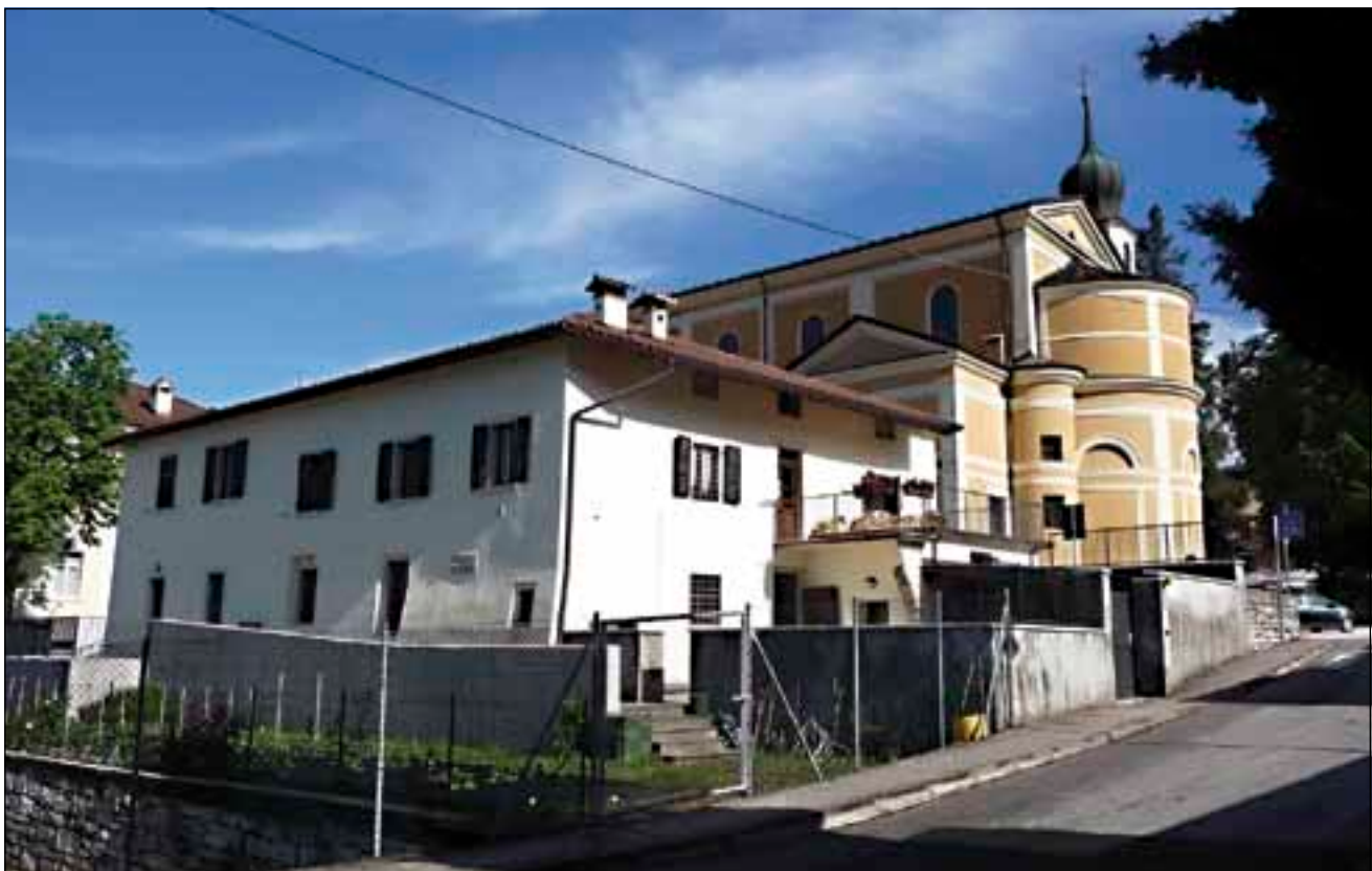
La canonica ristrutturata.
